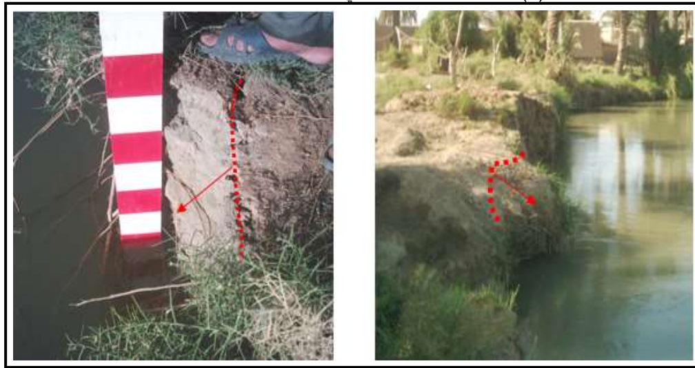
الشكل (4): ازدياد حجم الكتلة المنهارة بازدياد ارتفاع الكتف.
